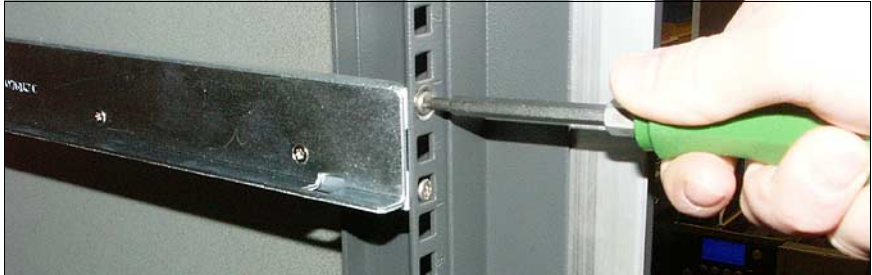
Bild 27: Rechte Gleitschiene montieren (Vorderseite Rack)
