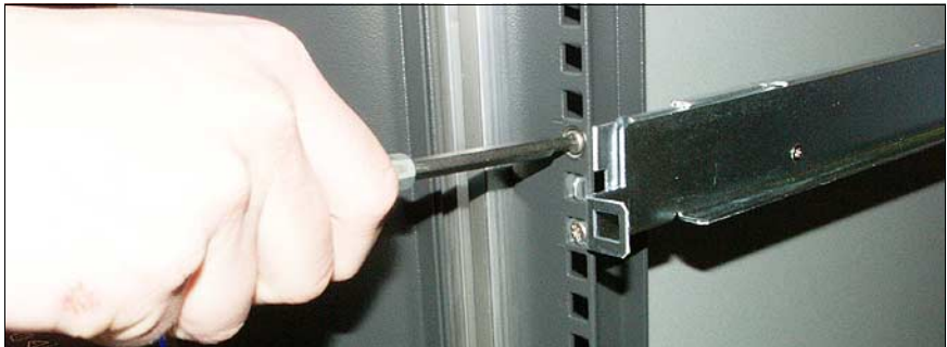
Bild 28: Rechte Gleitschiene montieren (Rückseite Rack)
